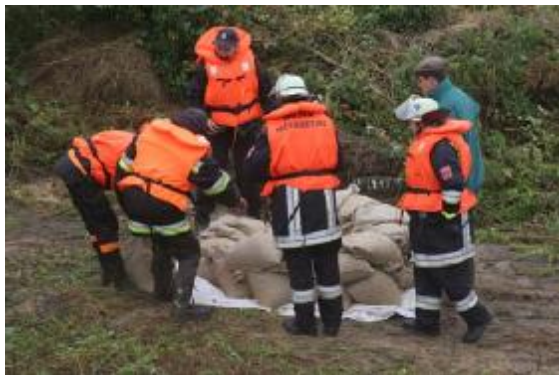
fot. Pozorowane działania zapobiegające przesiąkowi wału przeciwpowodziowego na rzece San.
