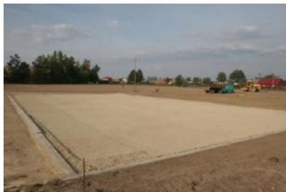
fol. Boisko do gry w koszykówkę w fazie budowy.
