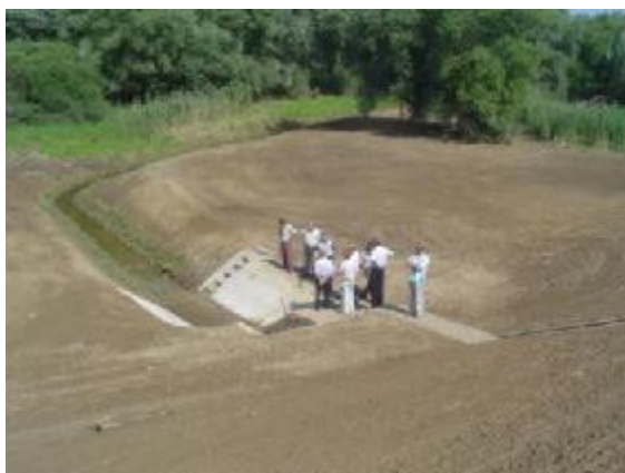
fot. Odbiór śluzy na rzece Strachockiej.
